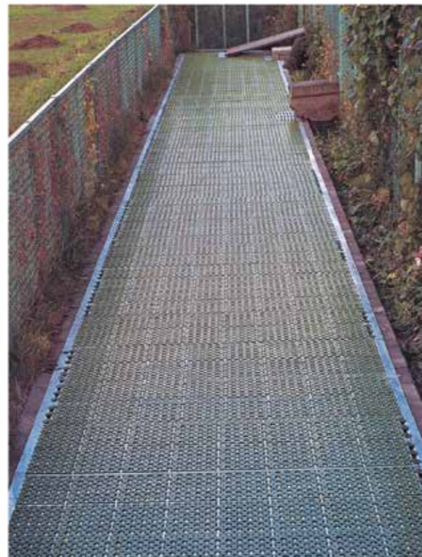
クリークウォークカバー施工後(滑り止め・落葉対策・脱輪防止・溝隠し)
