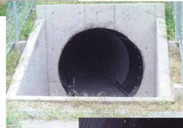
▲トンネル外観
