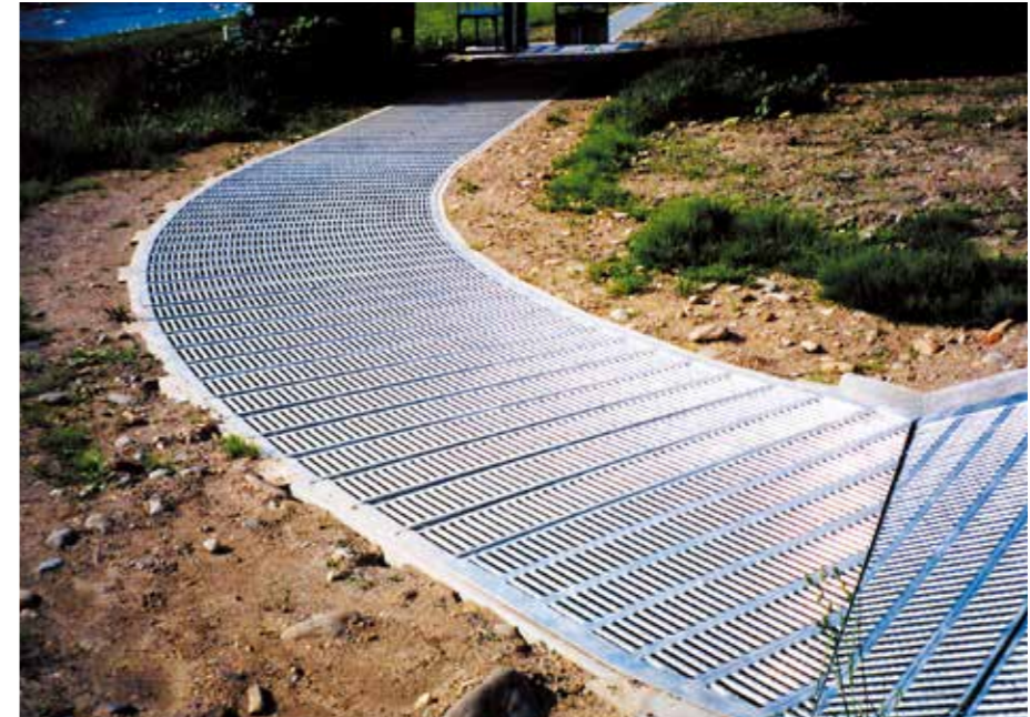
▲傾斜切断加工
