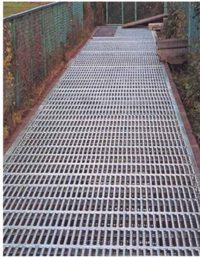
クリークウォーク施工後
