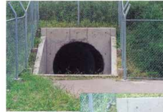
▲トンネル外観
