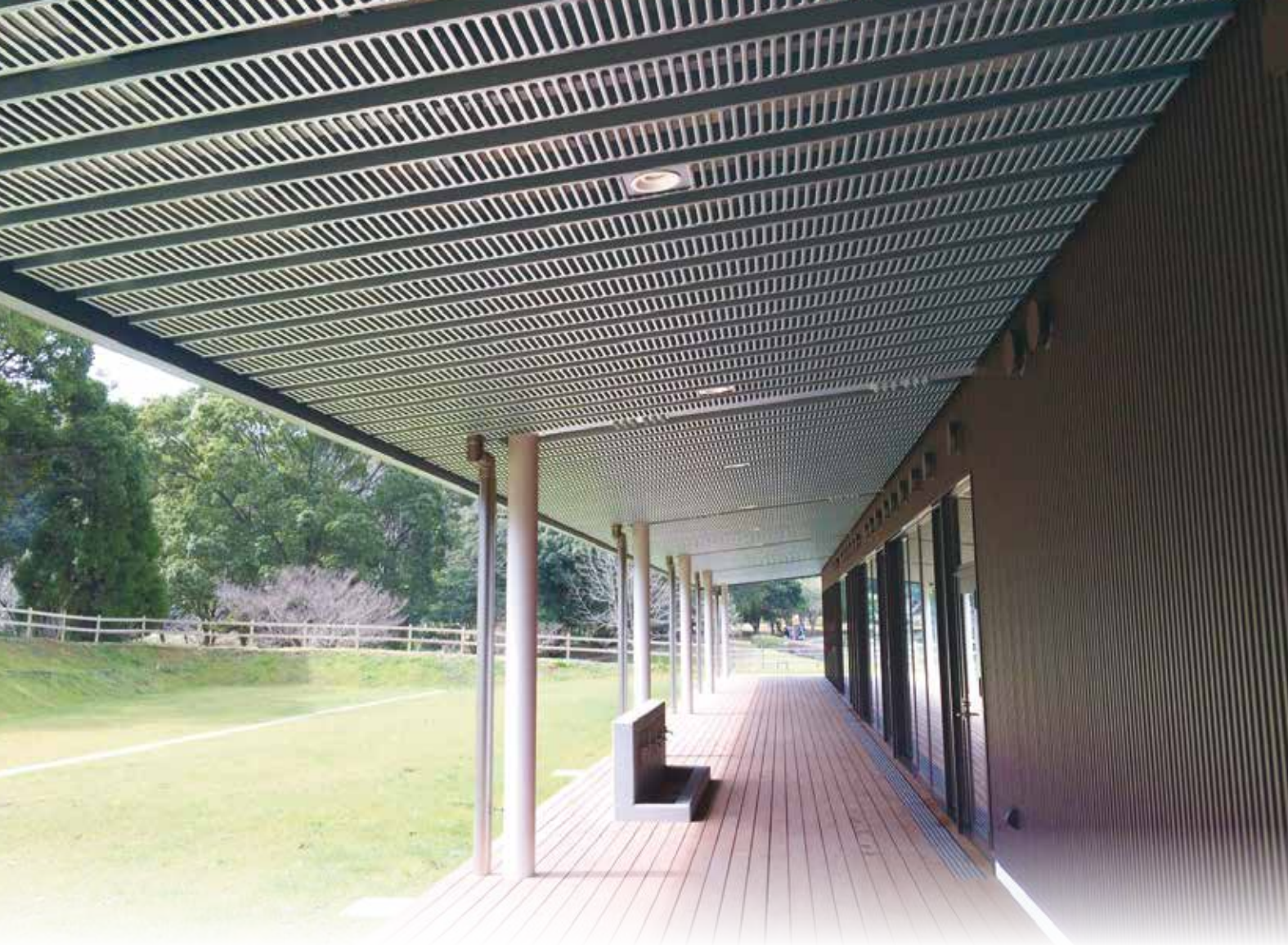
ファイン X (MF 型) : 天井施工例
